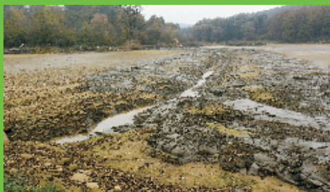
Pro odvodnění sedimentů byla prohloubena odvodňovací strouha
